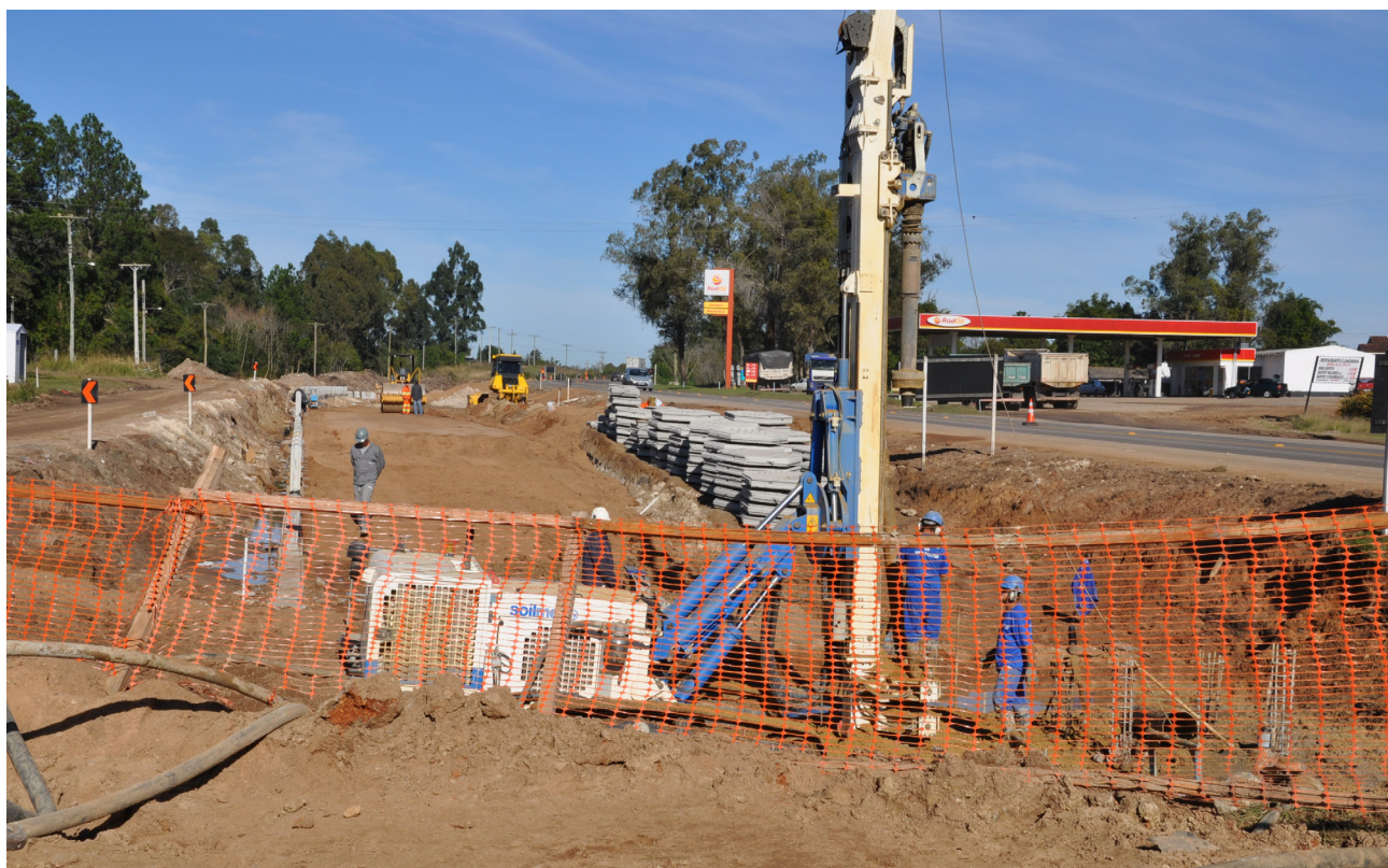
Após a execução do aterro, que começou em maio, a construtora SBS realizará as etapas de fundação e colocação de pilares e tabuleiros
