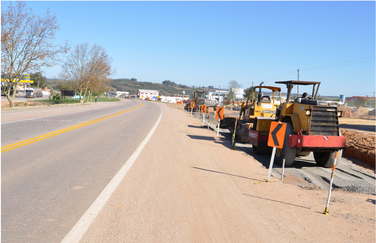
Obras avançam na Rua do Turismo, importante via no perímetro urbano do município de Cristal e que pertence ao lote 06 do empreendimento
