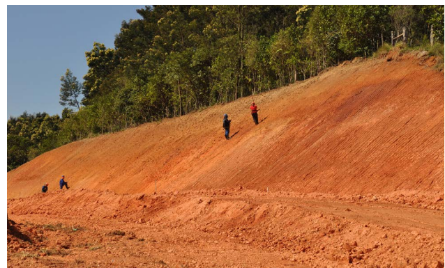
Aplicação de hidrossemeadura visa a proteção dos taludes
