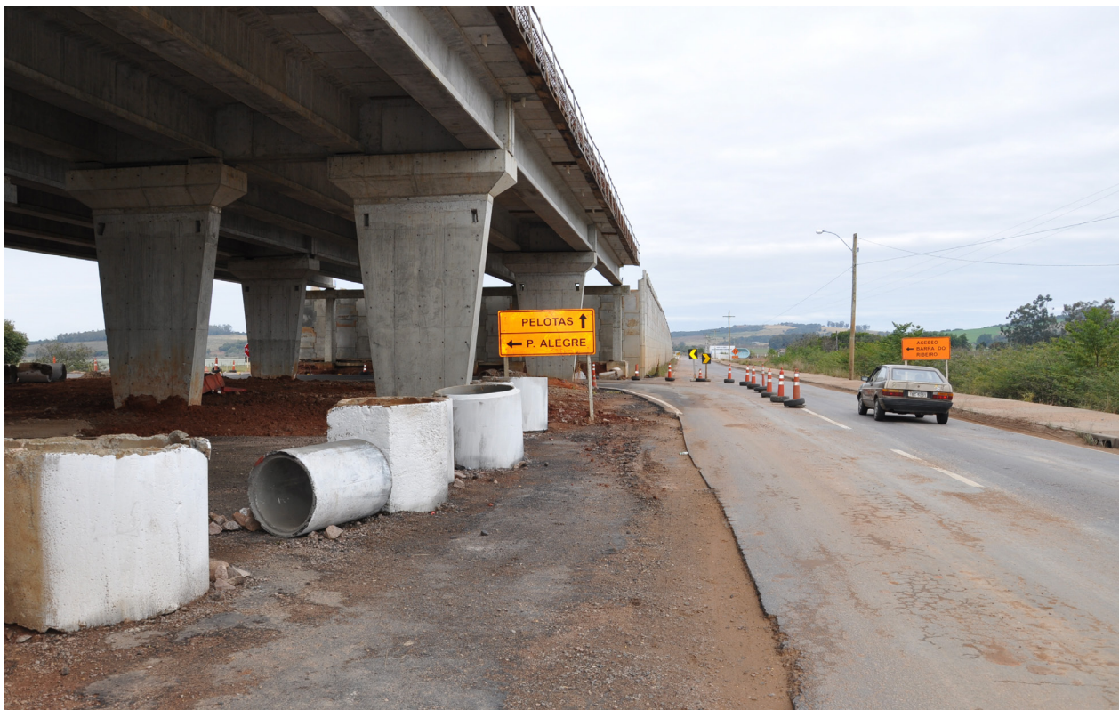
Para acessar Barra do Ribeiro, os veículos que estão no sentido Capital - Pelotas devem realizar uma conversão à esquerda por baixo do viaduto
