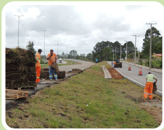
Realização de plantio de grama para o solo não sofrer erosão. Foto: Aline Ceolin
