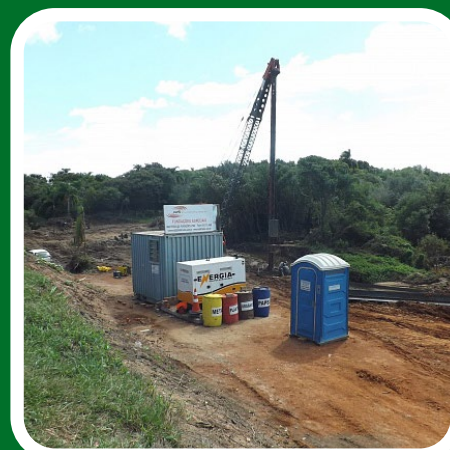
Utilização de Lixeiras e banheiros químicos nas frentes de obras/São Lourenço do Sul. Foto: Jackson Pilger
