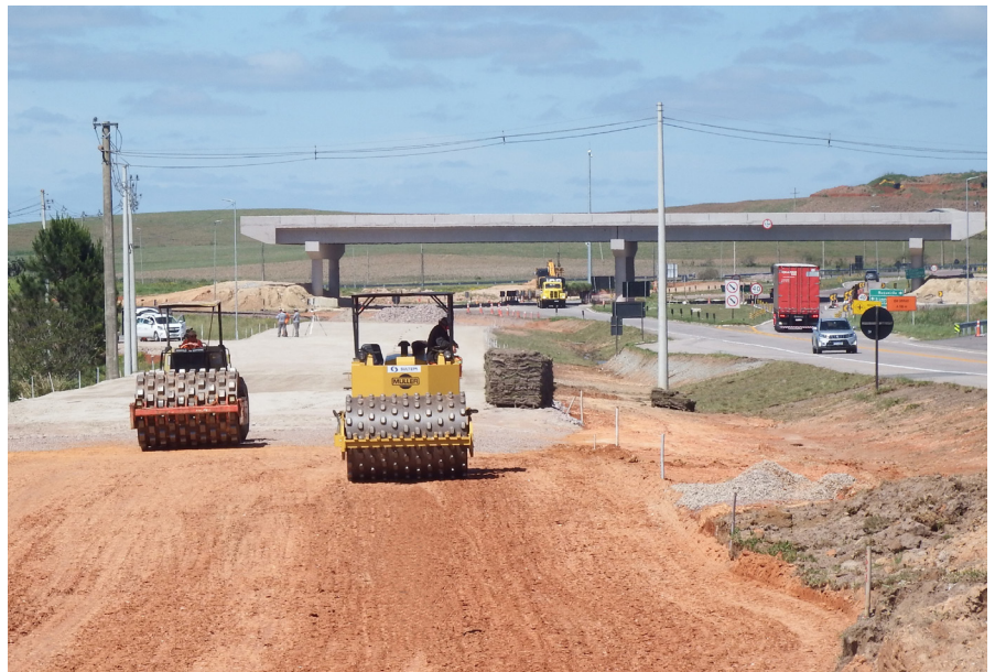
Obras da duplicação avançam no Lote 7
